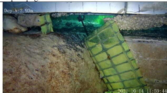
Figure 7 : Défaut structurel à la base du captage (vue sur le marais à l'extérieur depuis l'intérieur)
