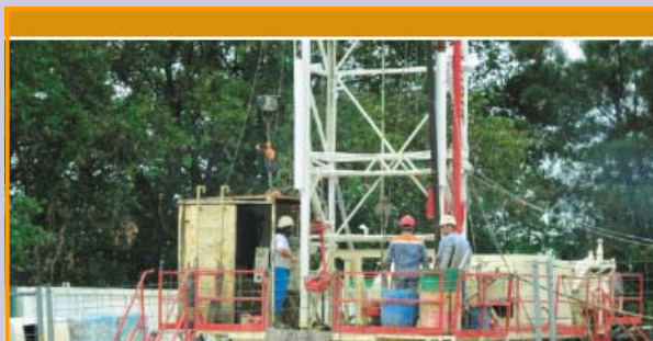
Forage et puits
