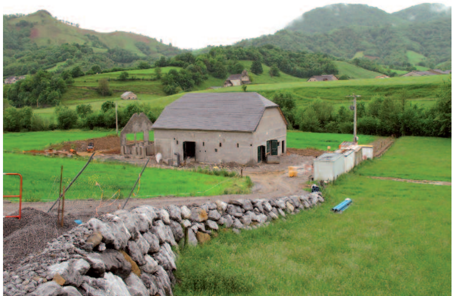
L'usine de traitement des eaux de la source des Cent Fontaines
