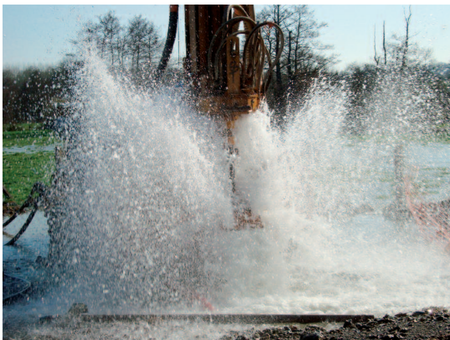
Forage du Buron, air-lift simple colonne (cliché ALEXIS ROBERT)
